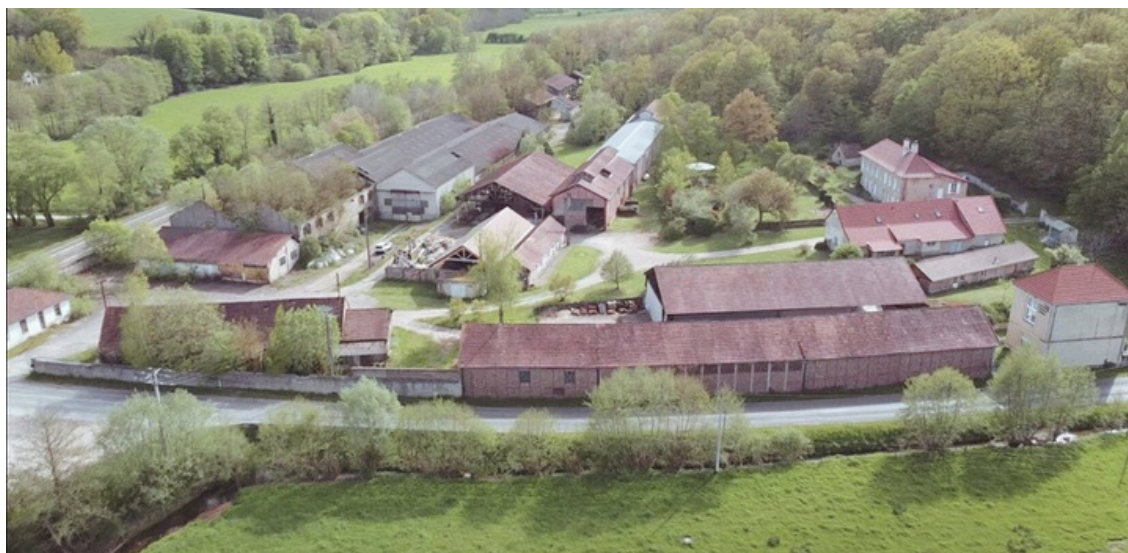
Vue d'ensemble du site des Forges de Perreuil
